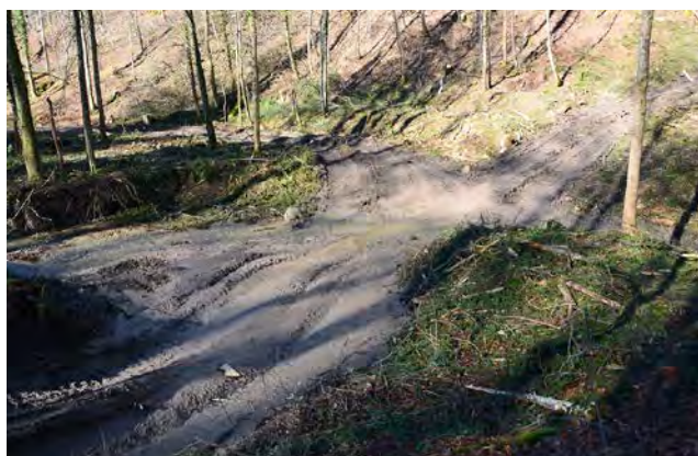
Tiefe Fahrspuren bis hin zu einer „Verbreiung“ des Bodens im Bereich einer Bachquerung, die zu dauerhaften Bodenschäden führen (Foto: Andreas Zehm).
