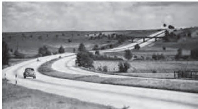
Abbildung 12: Abrupter Wechsel von Kreisbögen und Tangenten (oben). Im Gegensatz dazu ein kontinuierliches, durchschwingendes Fahrbahnband (unten) (Fotos: Hans Lorenz, in TUNNARD u. PUSHKAREV 1981, 200)
