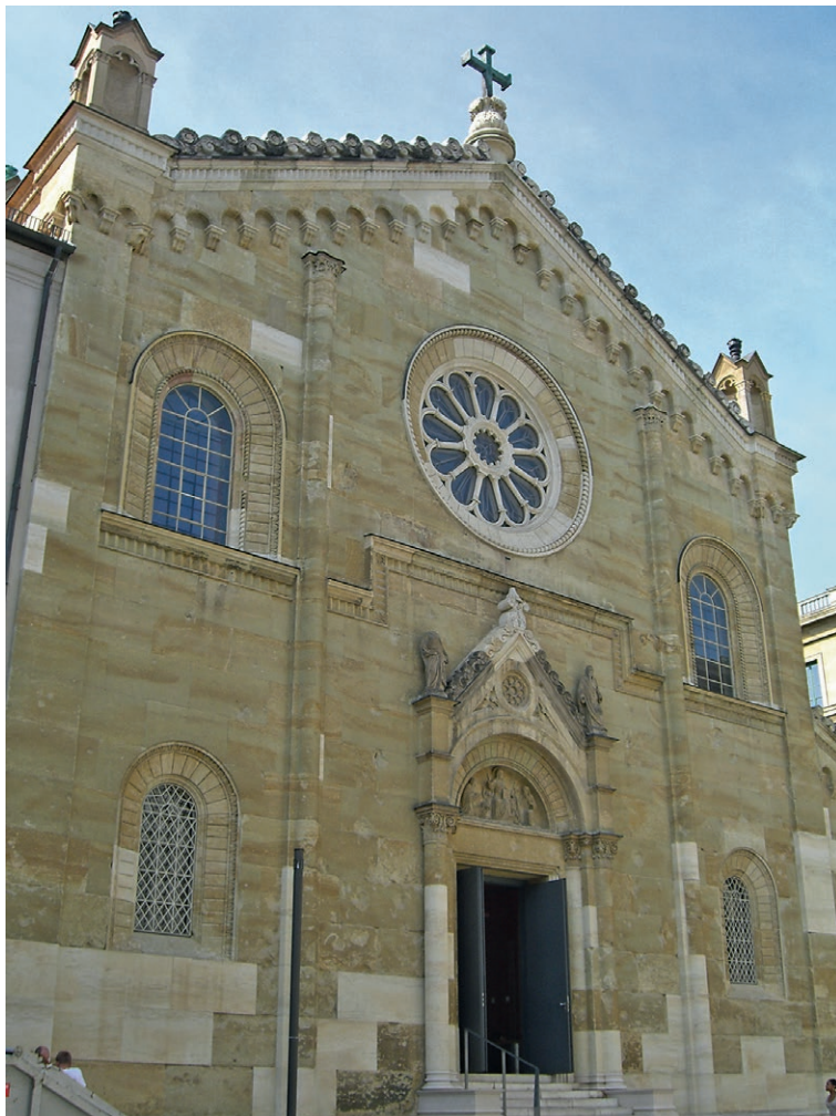
Abb. 32: Fassade der Allerheiligen-Hofkirche in München nach dem Austausch einiger Mauersteine mit Saaler-Grünsandstein.
