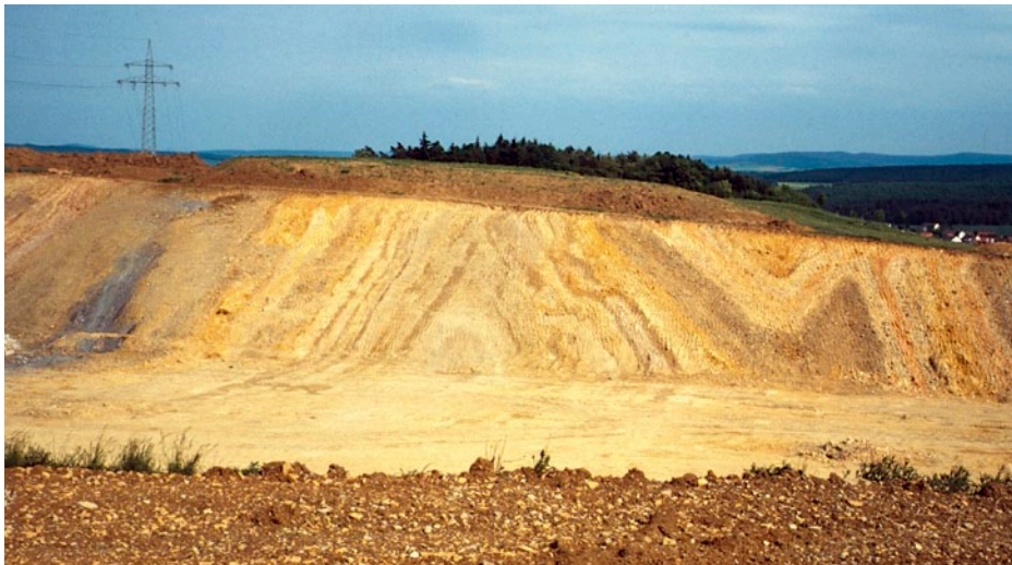
Ein seltener Aufschluss in der Heustreuer Störungszone: verfaltete und verschuppte Gesteine des Muschelkalks und des Keupers im Böschungshang; Blick nach Südosten, Aufnahme während des Baus der Autobahn A71
