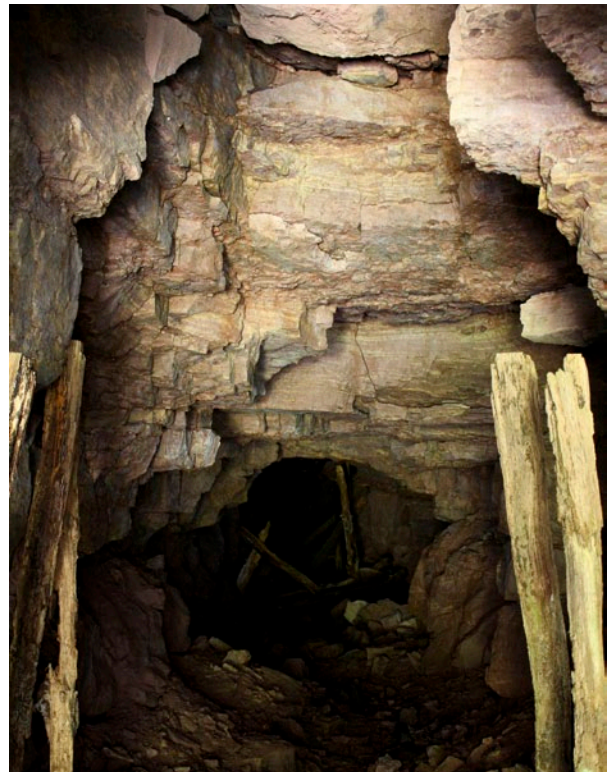
Der Erichstollen wurde in den Sandsteinen der Hardeggen-Formation angelegt und führt ca. 500 m nach Norden zum abbauwürdigen Barytgang des Marienschachtes.
