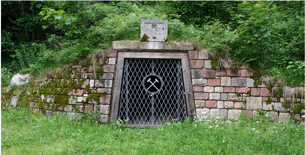
Das Mundloch des Rudolf-Stollens der Schwerspatgrube Marie bei Oberbach
