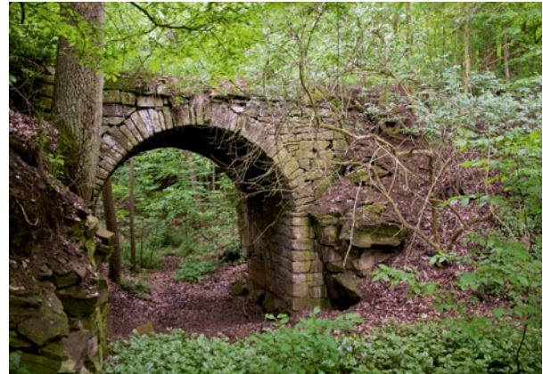
Die Steinbrüche südöstlich von Egenhausen liegen auf unterschiedlichen Niveaus. Eine Brücke aus Werksandstein ermöglicht den Zugang zum höher gelegenen Bruch.
