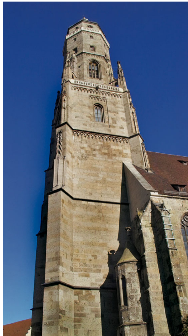
Der „Daniel“-Turm der St. Georgskirche wurde aus dem in umliegenden Steinbrüchen gewonnenen Suevit erbaut.
