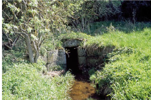
Eine abflusslose Senke im Moränengebiet südlich von Grafing wird bei Eisendorf durch einen aus Nagelfluhblöcken gemauerten Stollen entwässert.
