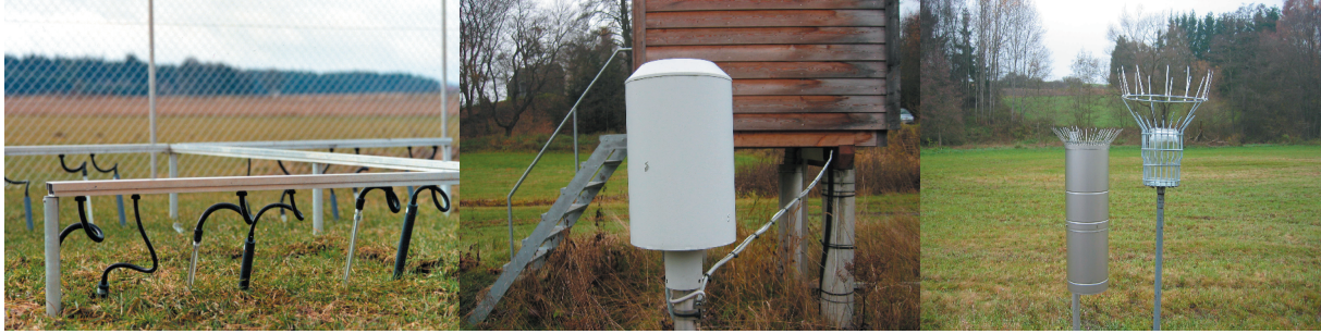
Abb.5: Kabel und Leitungen zu Sonden und Saugkerzen (links); Niederschlagsgeber (Mitte) sowie Bulksammler (Organik) und Bergerhoffsammler (Anorganik) (rechts).
