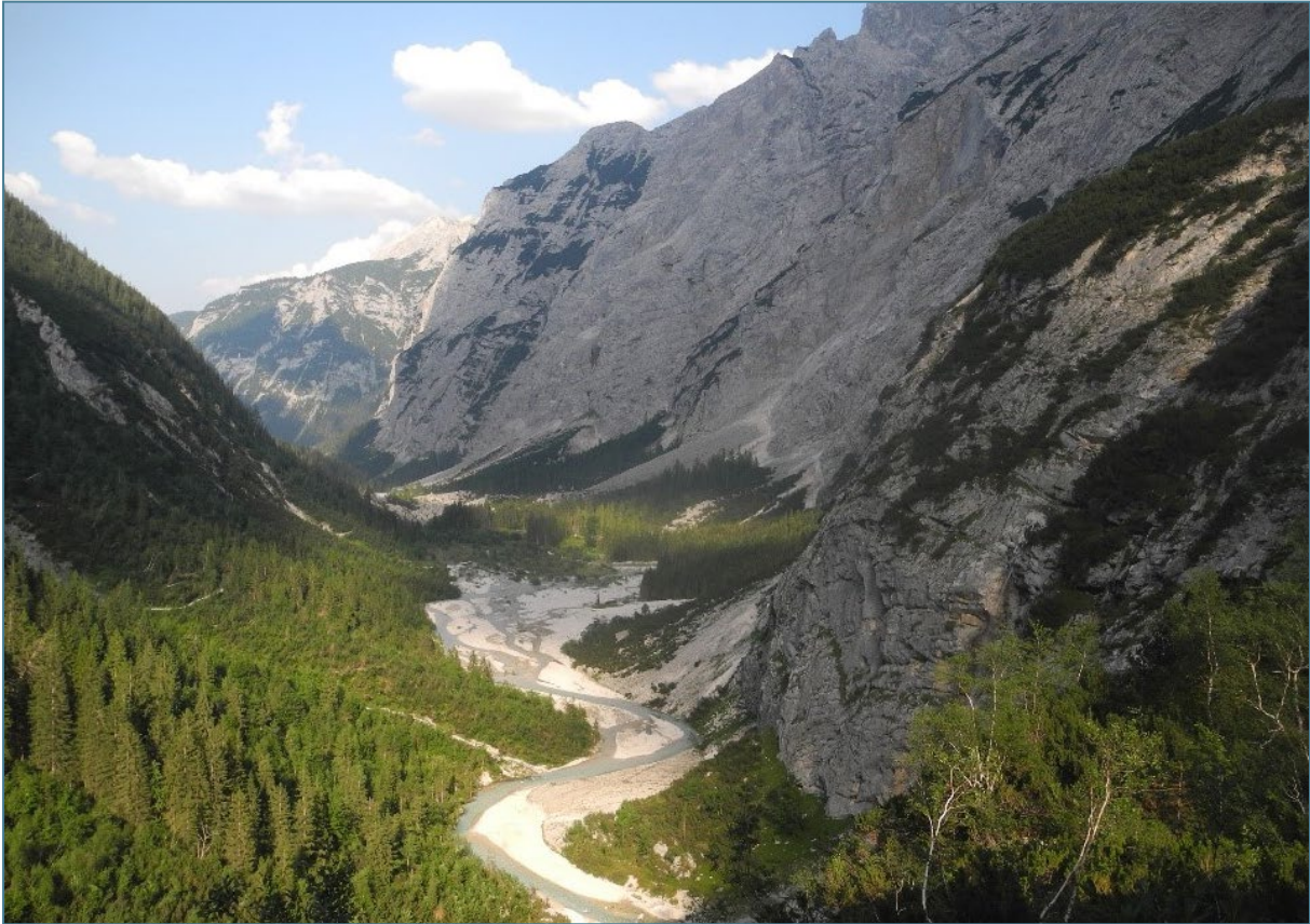
Abb. 16: In Bildmitte ist die Ablagerung des Steingerümpel zu sehen, die stromaufwärts zu einem Sedimentanstau geführt hat.
