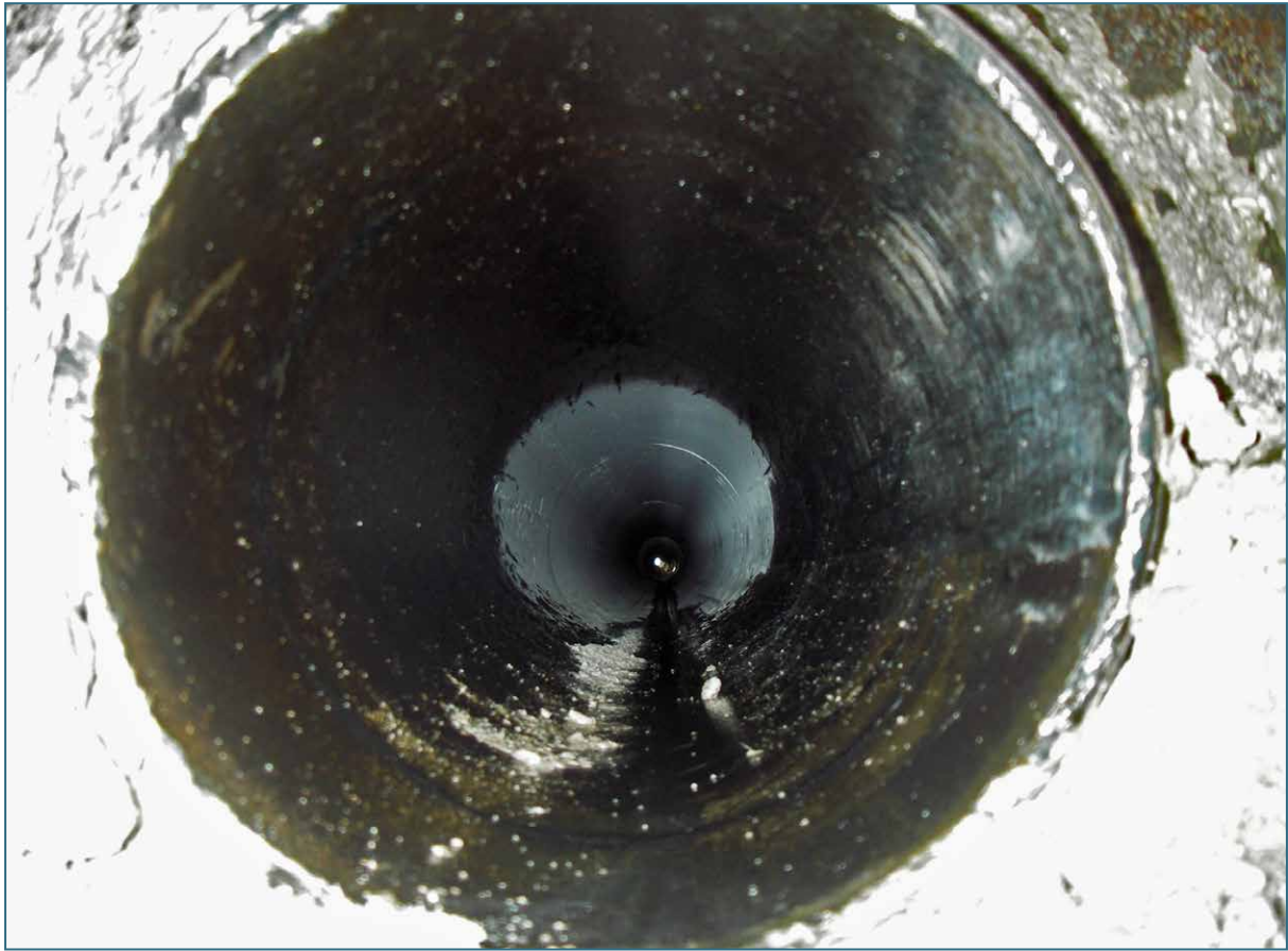
Abb. 3-8: Blick durch das 44,5 m lange Bohrloch, das fast keine Abweichung von der Geraden aufweist. Der kleine Lichtpunkt in der Mitte der Abbildung zeigt den Durchstichpunkt des Bohrlochs auf der Nordseite des Zugspitzgipfelgrats an.
