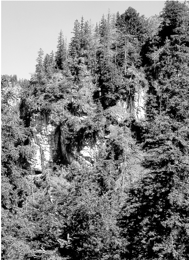
Abb. 2. Blick von der „Kanzelkehre“ der B 308 nach NW auf den Kleinen Jochschrofen; die vom rückwärtigen Gebirge vollständig abgetrennten Felstürme oberhalb der Oberjochstraße sind in sich stark zerklüftet.
