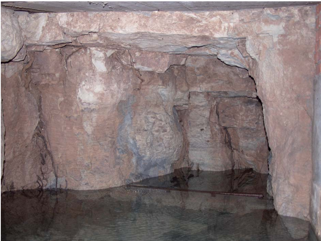
Abb. 3-5: Quellstollen im Bereich des dolomitischen Mittleren Burgsandstein (Hohenmühle, Viereth).
