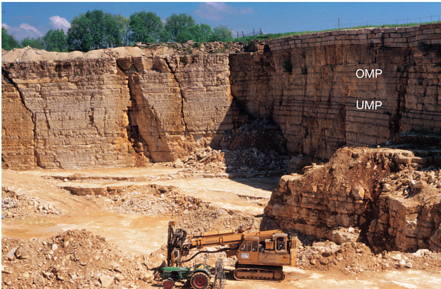
Abb. 3-5. Dickbänke des Treuchtlinger Marmors im Steinbruch Schöpfel E Petersbuch, mit Verkarstungserscheinungen an Klüften und Kleinabschiebungen. – UMP: Untere Mergelplatte, OMP: Obere Mergelplatte.
