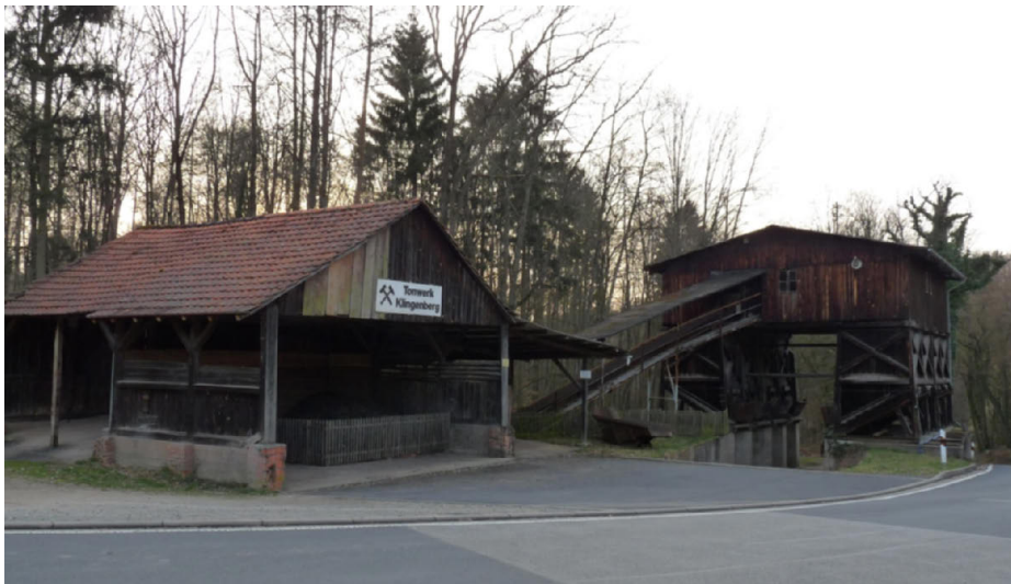
Abb. 4: Die westlich der Kreisstraße MIL 2 mit Bezug zum Tonbergwerk Klingenberg im Abschlussbetriebsplan gesicherten technischen Sachzeugen Lagerbox für Rohtonschnitzel, Kettensteigförderer und Bunkeranlage (von links nach rechts).
