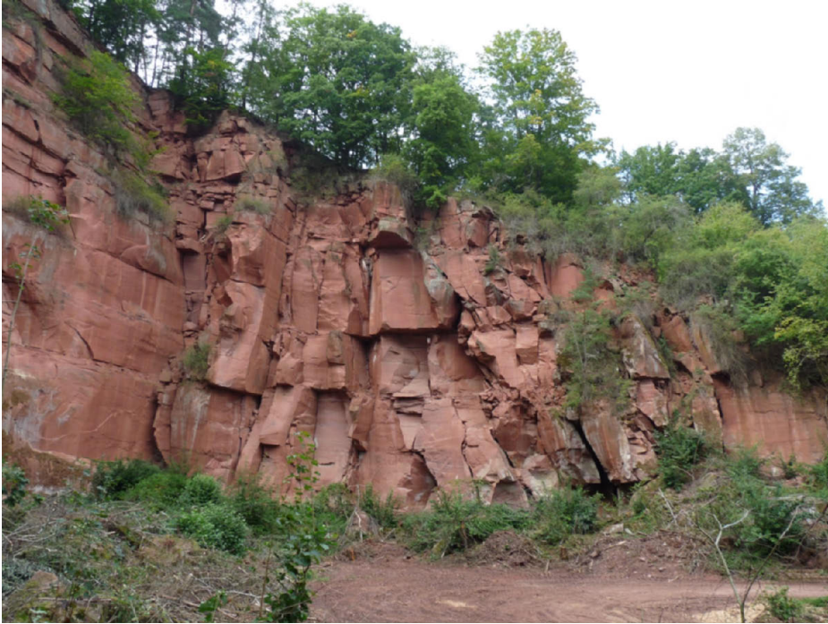
Abb. 5: Steinbruch im Miltenberger Sandstein in der Mainhölle NNW Bürgstadt (E 32 519.070:N 5.508.290) mit ausgeprägter Hangzerreiung und Talzuschubtendenz. Bis zu 7 m mchtig entwickelte Sandsteinbnke rechtfertigen die Namensgebung Dickbank-Sandstein.
