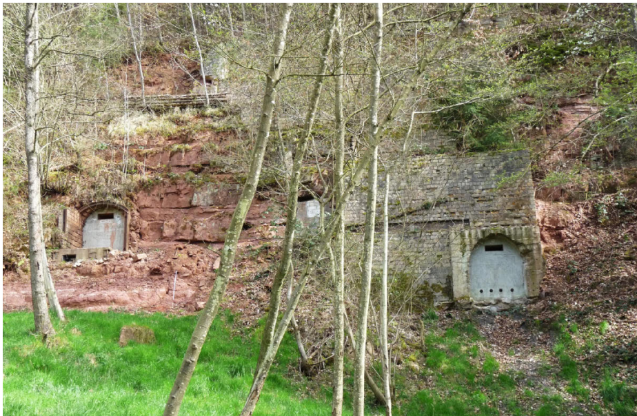
Abb. 22: Verschlossene Mundlöcher des Tages- und Förderbandstollens zum Blindschacht 21 an der östlichen Grubenwand in der Hardeggen-Wechselfolge jenseits der Randstörung 18 (Klingenberger Sprung)
