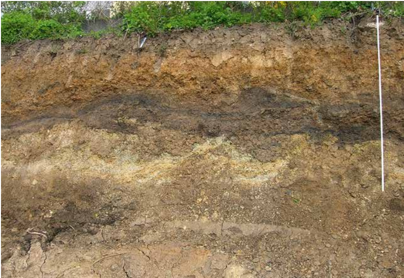
Abb. 30: N-Wand einer Baugrube in Haßfurt (Lage etwa R 43 93 910, H 55 45 765). Erkennbar ist der durch Kryoturbation und dadurch wellenförmig verformte Unterer Keuper (Obere Tonstein-Gelbkalkschichten) unter geringmächtiger Bodenbildung, Maßstablänge 2 m.
