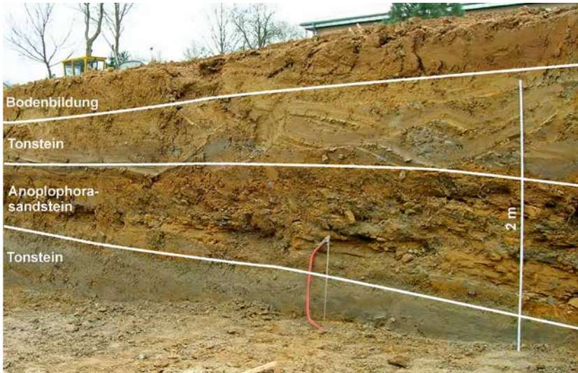
Abb. 7: Baugrube südlich des Hauptbaues des Krankenhauses Haßfurt (R 43 93 650, H 55 45 850), Frühjahr 2011 (Blick NW). Erkennbar ist das deutliche Einfallen der Schichten nach SE (ca. 1,5^{\circ} – 2^{\circ} ).
