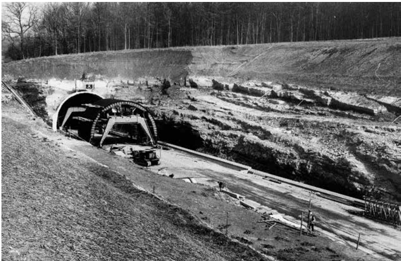
Abb. 10: Südportal des Mühl-Berg-Tunnels mit aufgeschlossenem Röt Quarzit.
