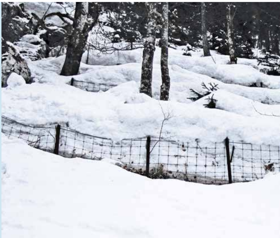
■ Schneezäune halten die Schneedecke fest und verhindern Schäden an der Waldverjüngung durch Schneegleiten.
