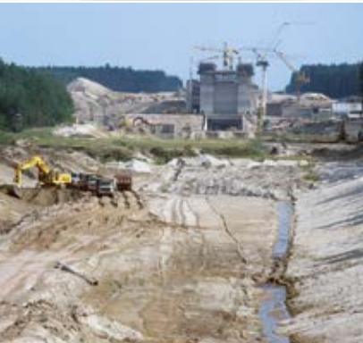
Bau des Rhein-Main-Donau-Kanals 1983
