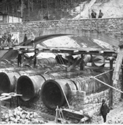
Bau des Walchensee-Kraftwerks
