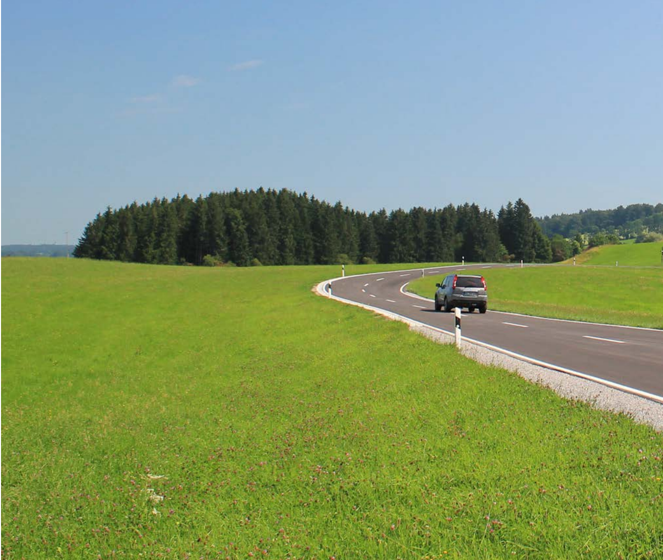
Seitenraum ohne gefährliche Hindernisse
