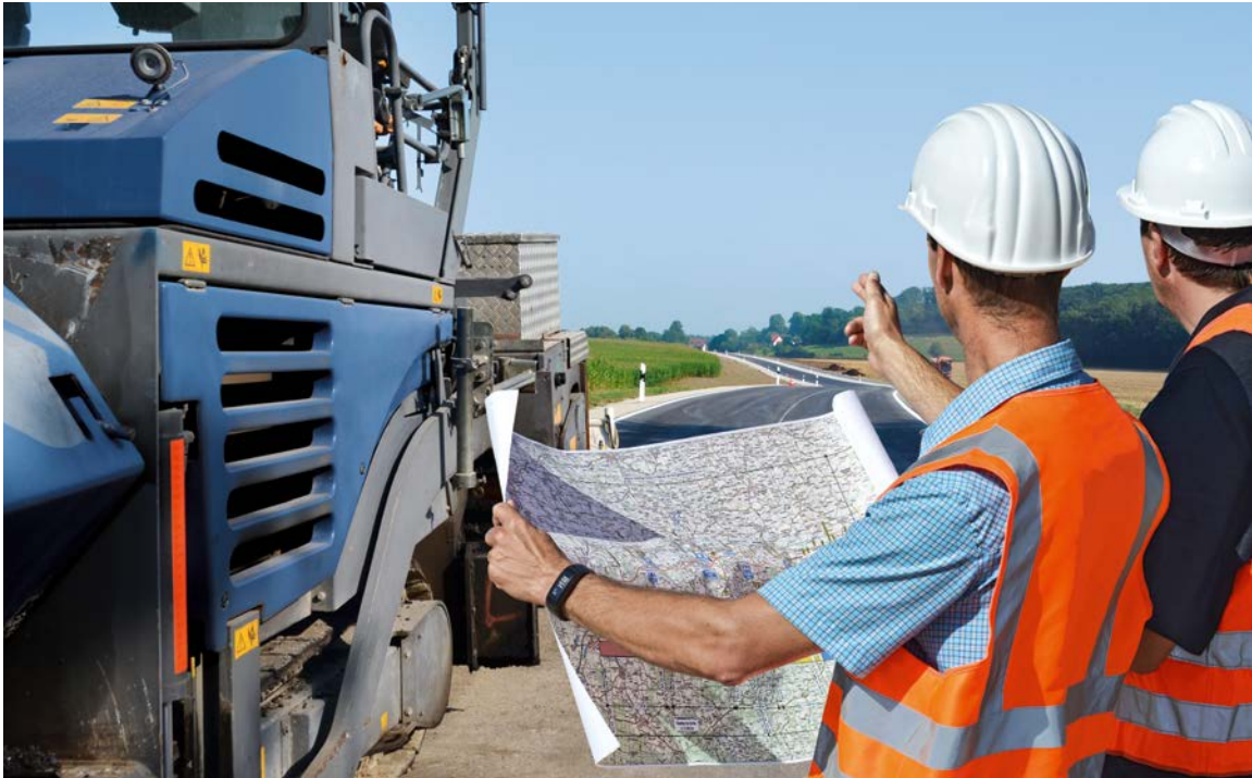
Kontinuierliche Bauaufsicht zur Erleichterung der Bauabwicklung und Qualitätssicherung
