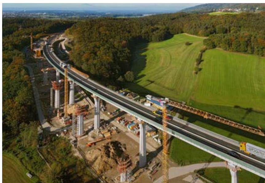
A3, Unterrieden viaduct
