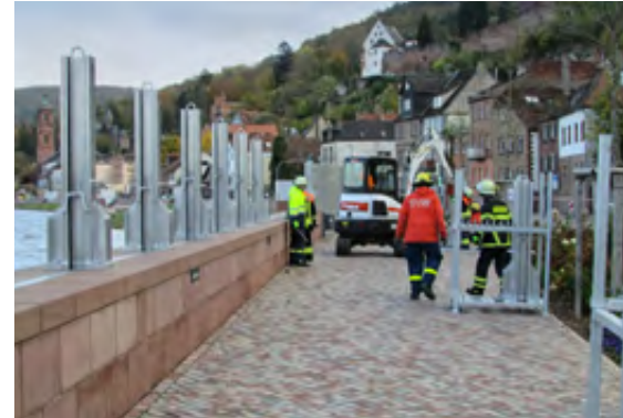
Erhöhung der Schutzmauer als Vorbereitung auf ein Hochwasserereignis
