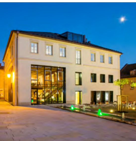
Gasthaus „Veicht“ nach Umbau mit neu angelegtem Vorplatz mit Gastgarten
