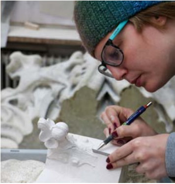
Werkstein-Anfertigung für eine Fiale
