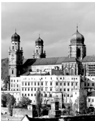
Dom St. Stephan zu Beginn der Instandsetzung, 1933
