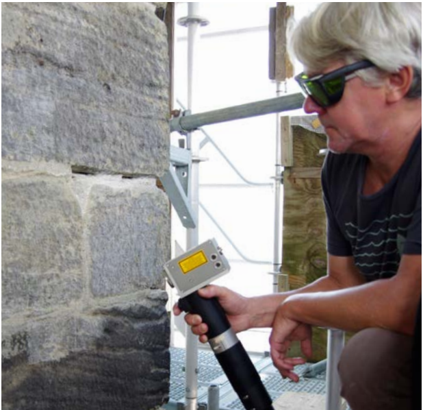
Reinigung Naturstein mit Laser- gerät am Bamberger Dom
