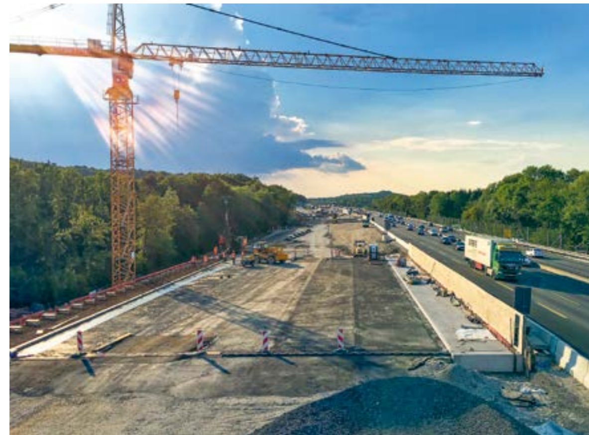
Neubau einer Brücke im Rahmen des Ausbaus der A 99 Ost. © Autobahndirektion Südbayern
