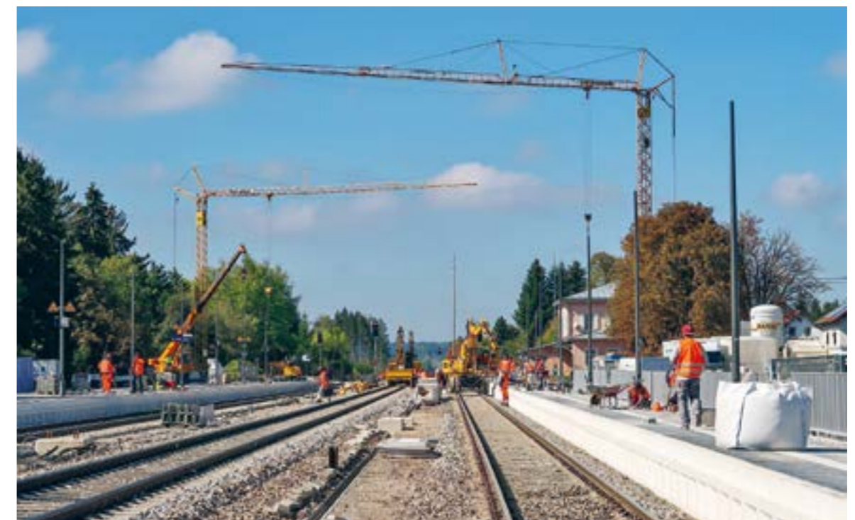
Umbau des Bahnhofs Türkheim Foto: Armin Franzke, DB AG
