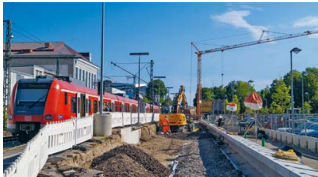
Barrierefreier Ausbau der S-Bahnhaltestelle Höllriegelskreuth © DB Netz AG
