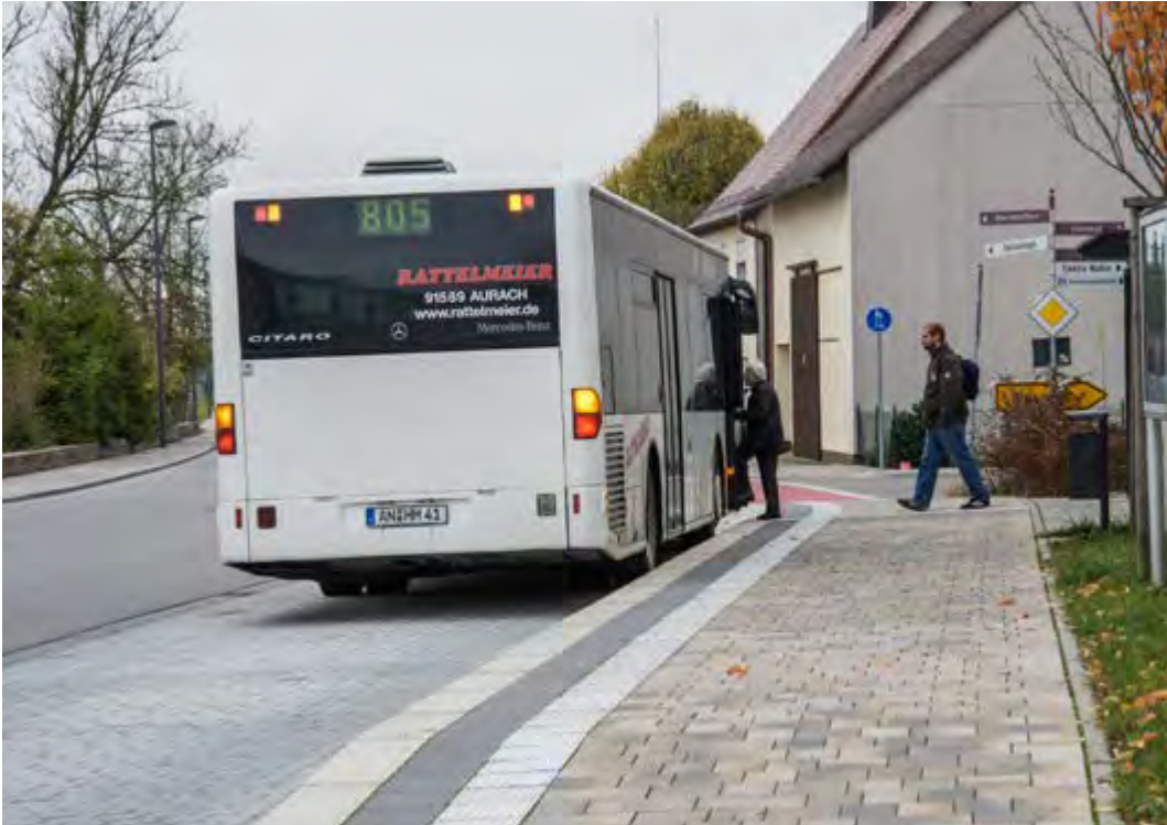
« Bushaltestelle mit Kasseler Hochbord und taktilen Bodenelementen
