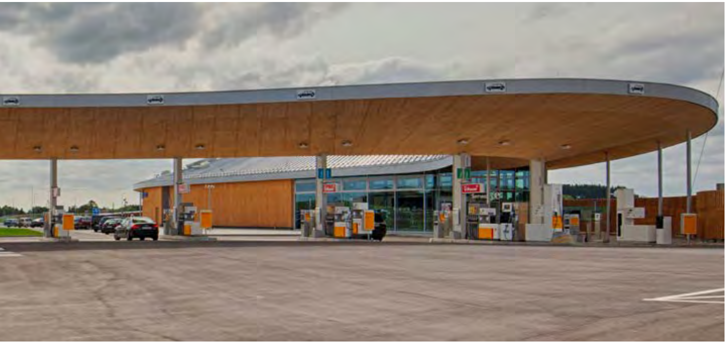
➤ A 9 Tank- und Rastanlage der Zukunft: Fürholzen West
