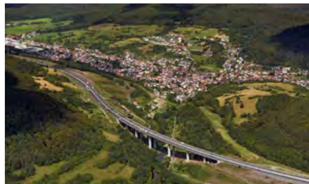
➤ A 3, Kauppenbrücke bei Waldaschaff; die neue Trasse wurde um bis zu 300 Meter abgerückt
