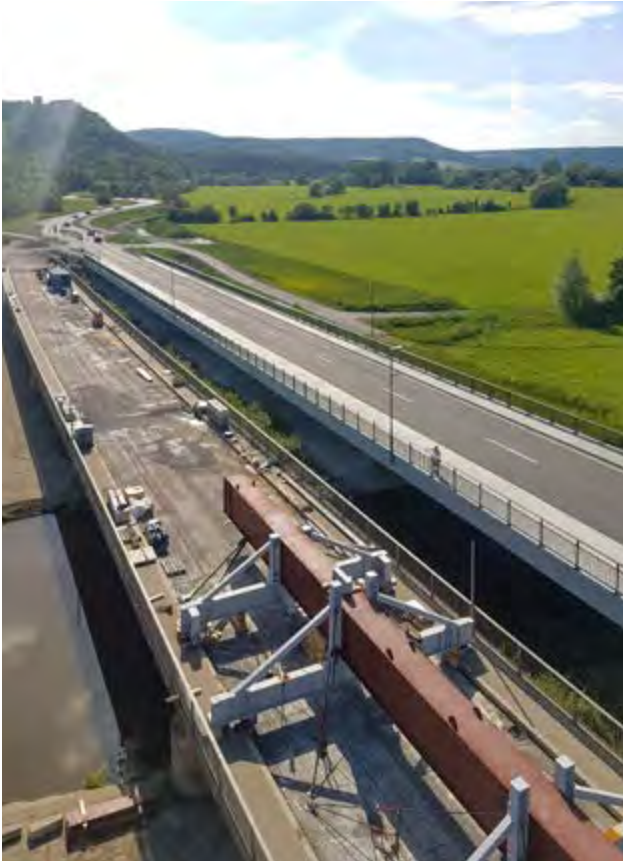
➤ Alte und neue Saalebrücke Hammelburg mit Versuchsstand auf der alten Brücke
