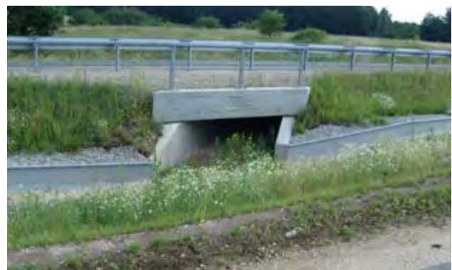
↪ Amphibienleiteinrichtungen an der B 470 bei Burk zwischen Forchheim und Wimmelsbach
