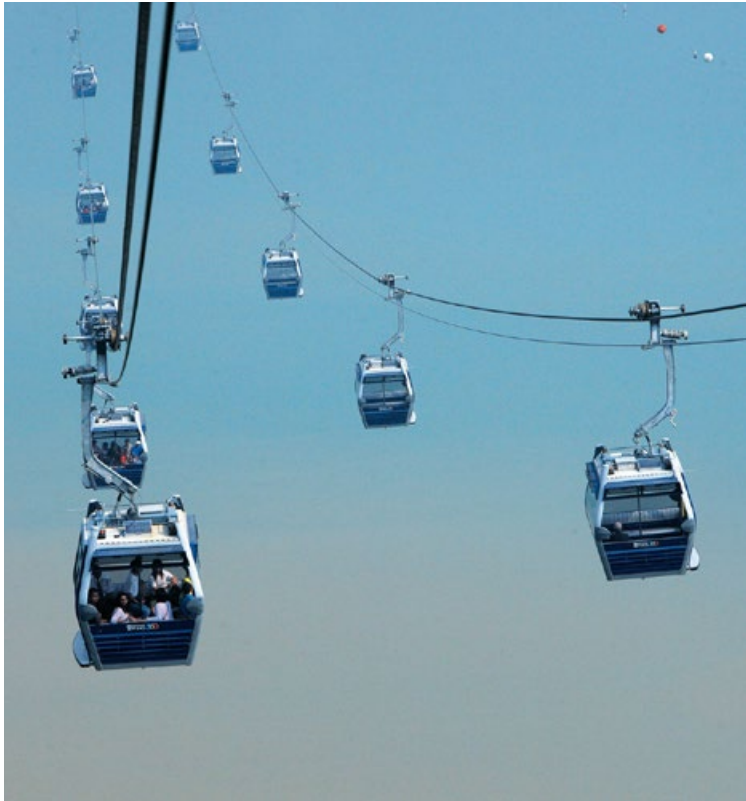
Zweiseil-Umlaufbahn in Hong Kong Quelle: Leitner
