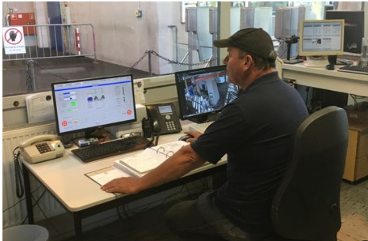
Betriebsleiter am Steuerstand Quelle: StMB
