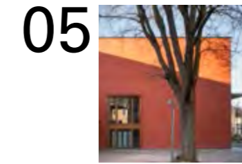
05 Institutsgebäude Universität Bamberg
