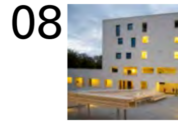
08 Wohnanlage »Jules et Jim« Neu-Ulm
