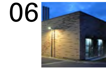
06 Energiezentrale Hochschule Aschaffenburg
