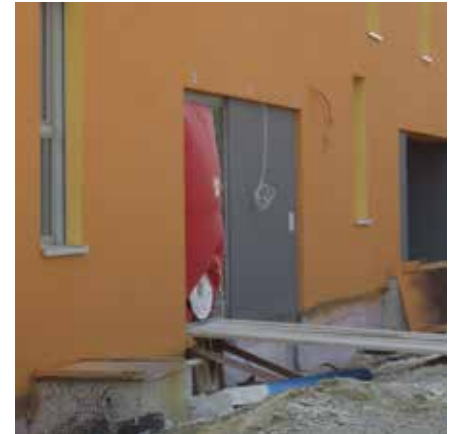
Abb. 170: Luftdichtigkeitsmessung während der Bauphase in München
