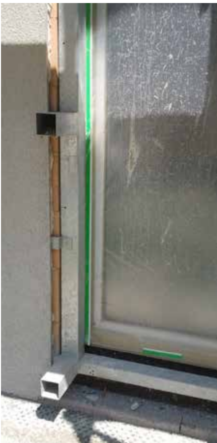
Abb. 141: Anschluss der Fensterrahmen
