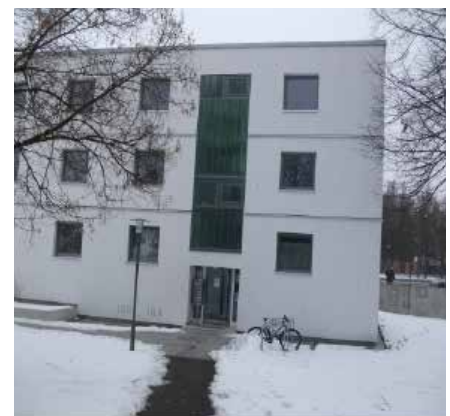
Abb. 175: Außenansicht in Augsburg nach der Sanierung
