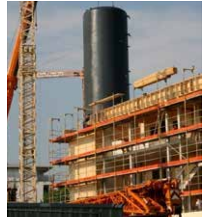
Abb. 78: Einbau des Pufferspeichers
