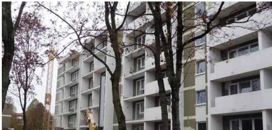
Abb. 34: Fassade kurz nach Beginn der Sanierungsmaßnahmen
