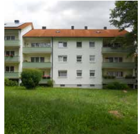
Abb. 13: Außenansicht vor Modernisierung
