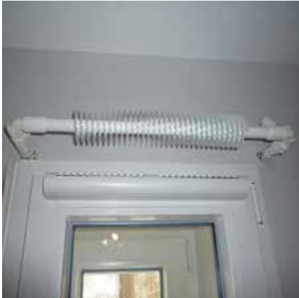
Abb. 21: Kastenfenster mit Rippenheizkörper
