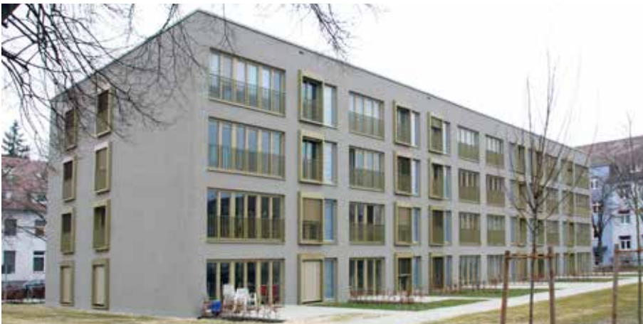
Abb. 133: Süd-West-Ansicht des Gebäudes
