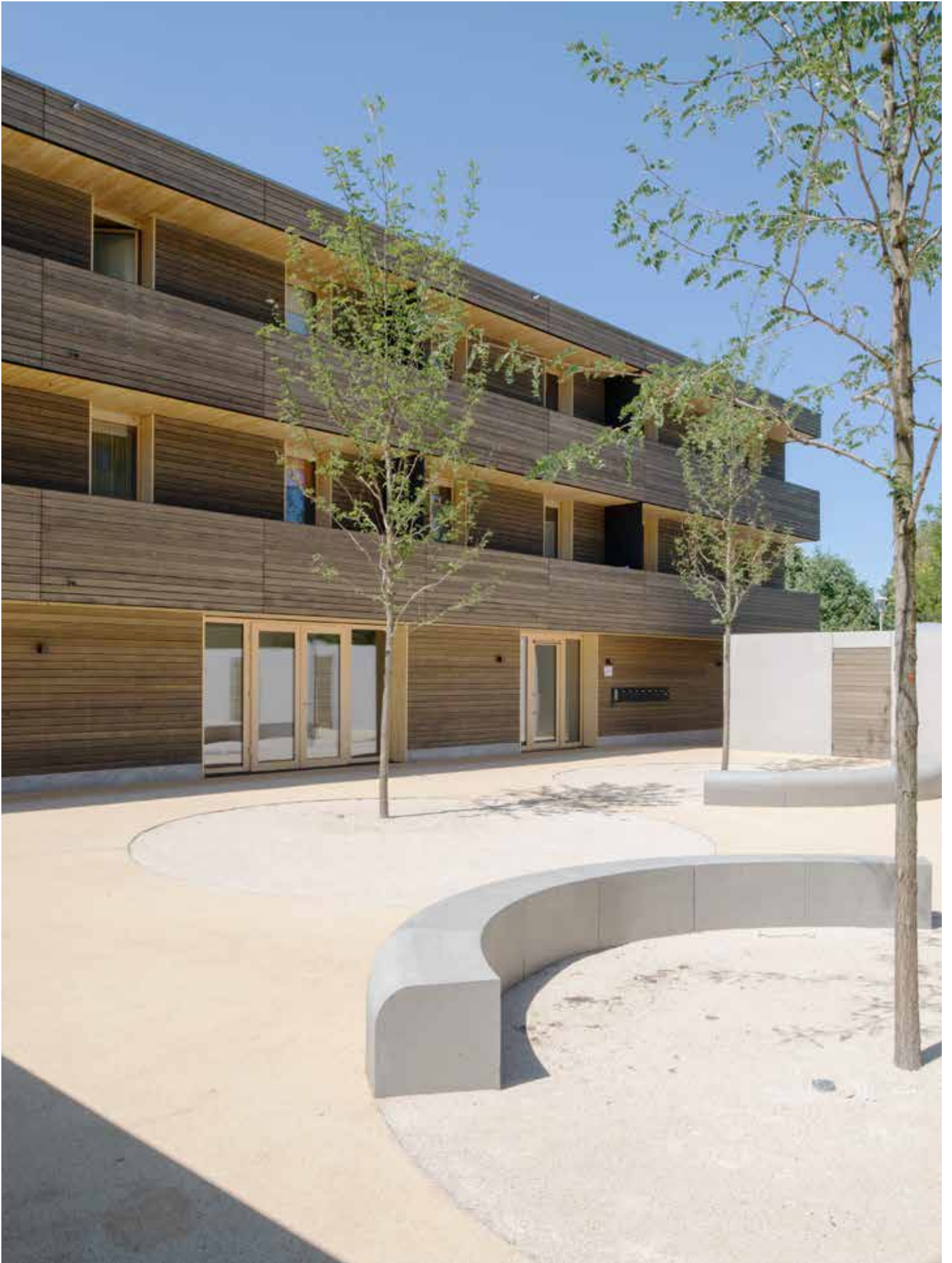
Abb. 45: Ost-Fassade zum gemeinschaftlichen Innenhof und Nebengebäude
