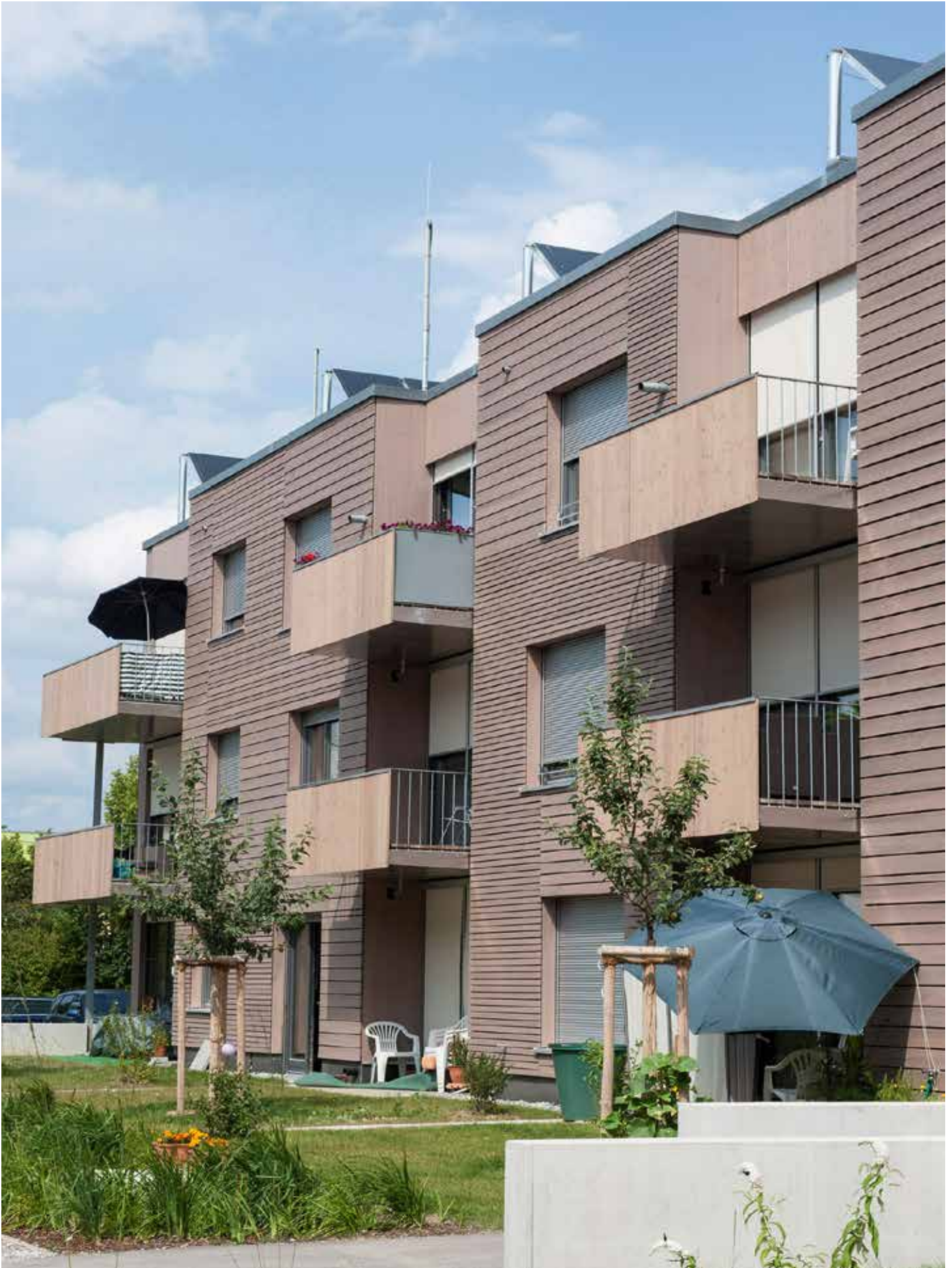
Abb. 84: West-Fassade mit privaten Freiflächen, Balkonen und der solarthermischen Anlage auf dem Dach
