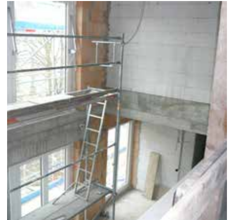
Abb. 179: Innenausbau in Neu-Ulm
