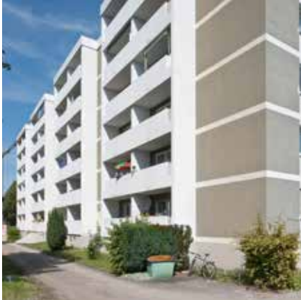
Abb. 156: Das Projekt in Augsburg vor der Sanierung
