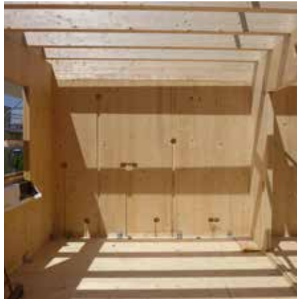
Abb. 75: Holzkonstruktion mit Aussparungen
