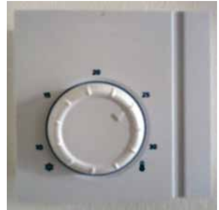
Abb. 123: Thermostatregler für die Fußbodenheizung
