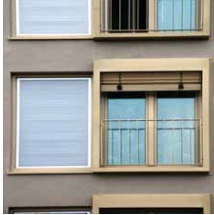
Abb. 166: GlassX-Element mit Latentwärmespeicher in Neu-Ulm
