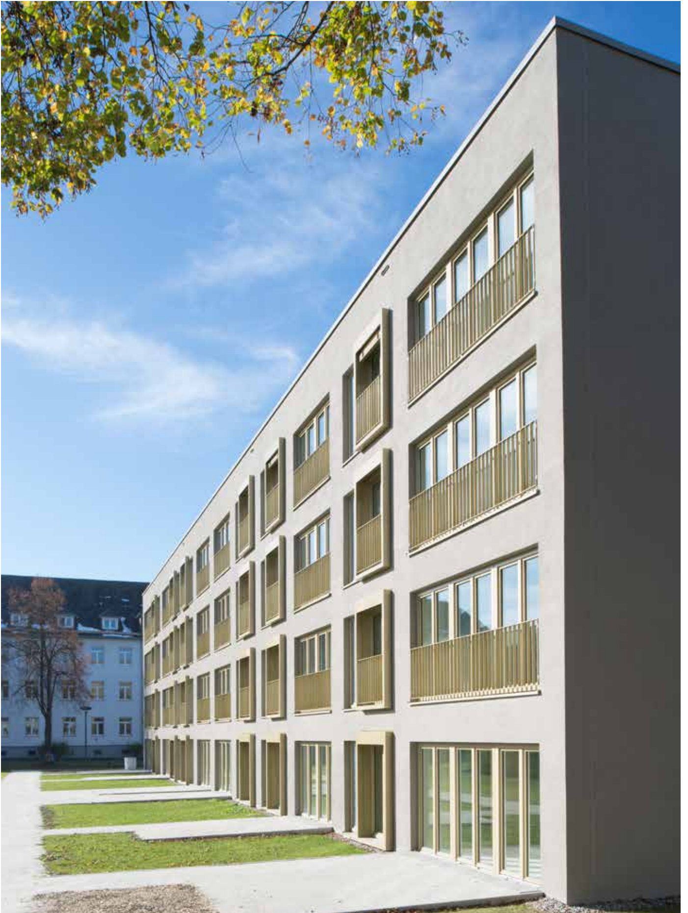
Abb. 128: Süd-Fassade mit privaten Freiflächen
