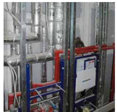
Abb. 59: Installationswand im Bad
