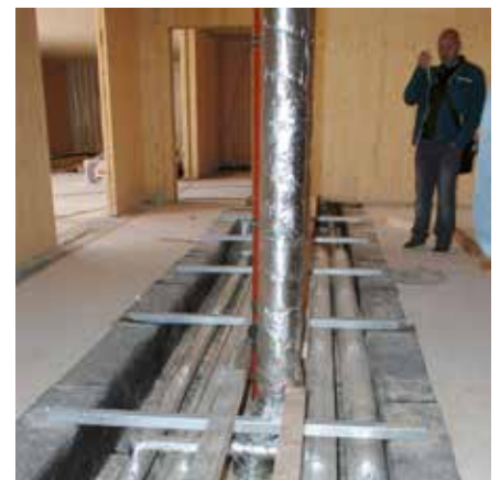
Abb. 58: Bodenkanal unter der EG-Bodenplatte
