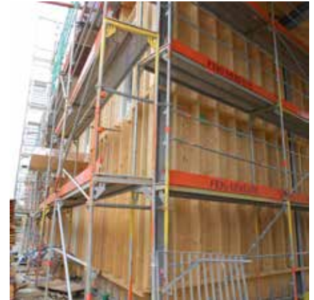
Abb. 76: Holzwand im Rohbau
