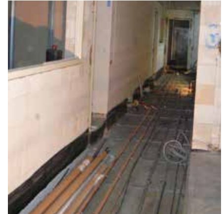
Abb. 143: Leitungsverteilung in der Erdgeschossdecke
