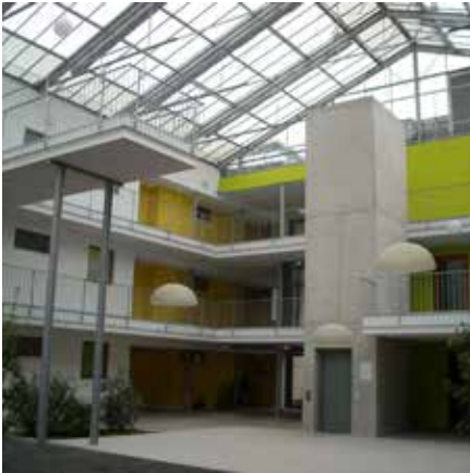
Abb. 92: Blick ins Atrium mit Erschließungsbereichen
