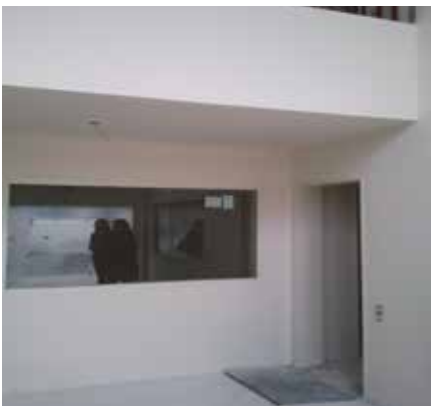
Abb. 140: Blick vom Gemeinschaftsbereich zu den Wohnungseingängen
