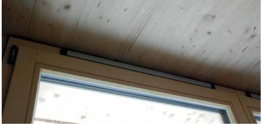
Abb. 61: Fenster mit Überströmöffnung
