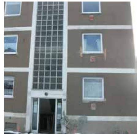
Abb. 173: Außenansicht in Augsburg vor der Sanierung
