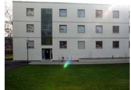
Abb. 44: Foto: Dreigeschossiger Baukörper
