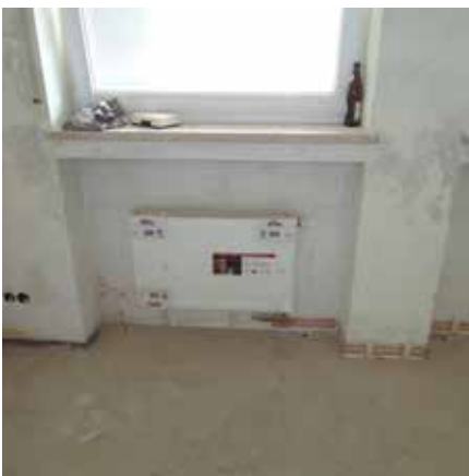
Abb. 41: Einbau des neuen Heizkörpers
