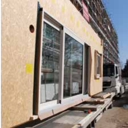
Abb. 35: Lieferung der neuen Fassadenelemente
