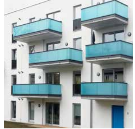
Abb. 167: Weit auskragende Balkone in Marktredwitz
