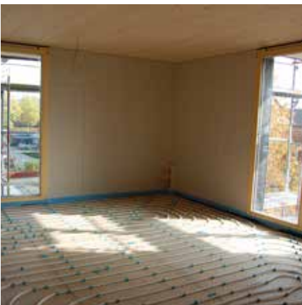
Abb. 63: Verlegte Schläuche für die Fußbodenheizung
