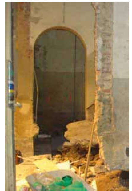
Umbaumaßnahmen zur Erreichung der Barrierefreiheit
