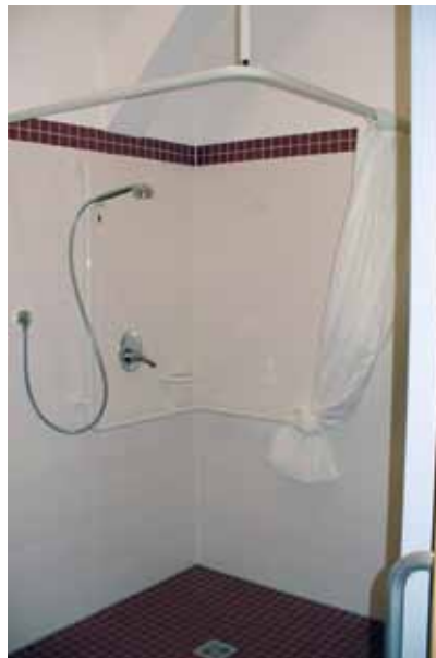
Augsburg | bodengleiche Dusche mit bereits eingebauten Haltegriffen
