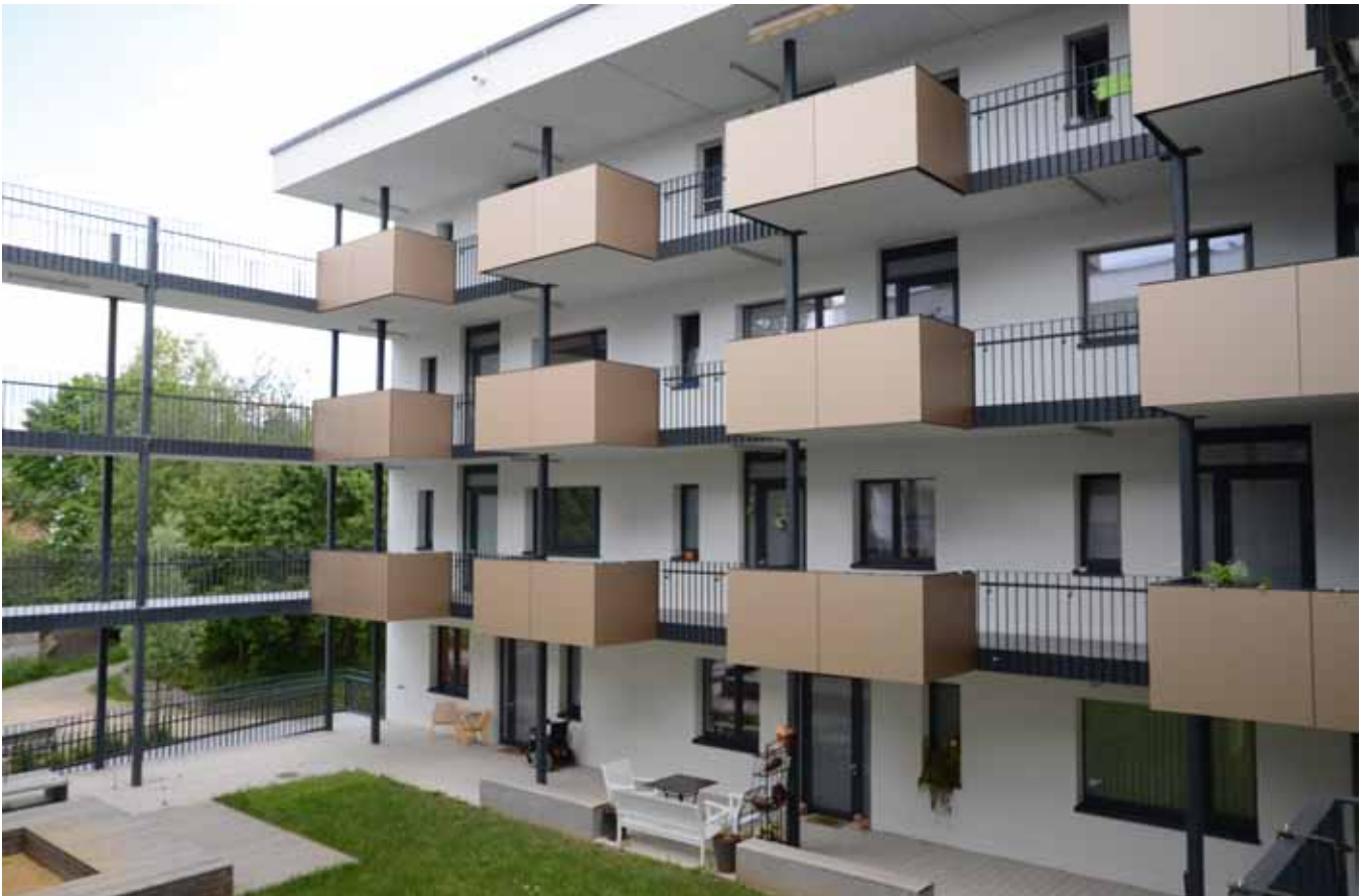
Hof | Aufweitungen der Laubengänge
