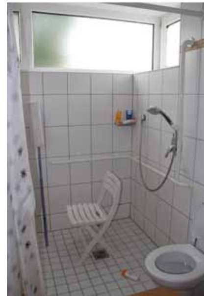
Bobingen | bodengleiche Dusche
