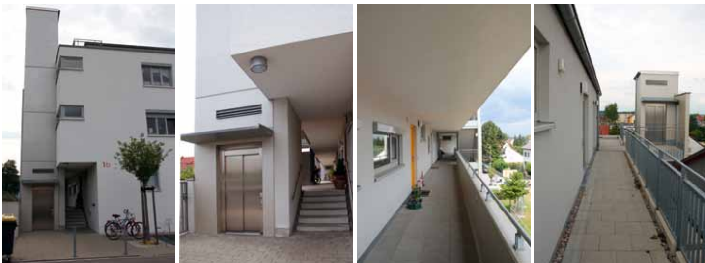
Die Kombination aus Aufzug und Laubengang ermöglicht eine barrierefreie Erreichbarkeit aller Ebenen
