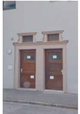
Neu-Ulm | ehemaliger Haupteingang wurde zum Nebeneingang und zweiter Haupteingang wurde zum Lagerraum
